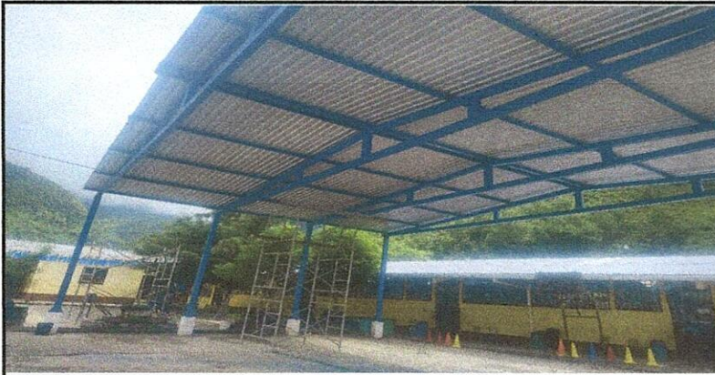
Foto 3: Se efectuaron trabajos correspondientes al entechado de la estructura, siguiendo las especificaciones del proyecto.
