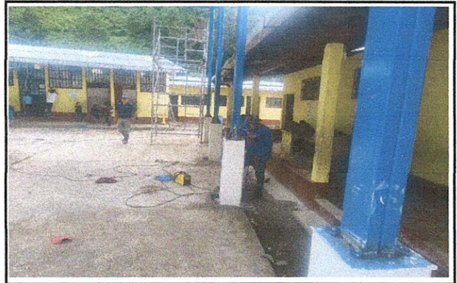
Foto 2: Instalación de columnas metálicas sobre las bases de concreto previamente fundidas.
