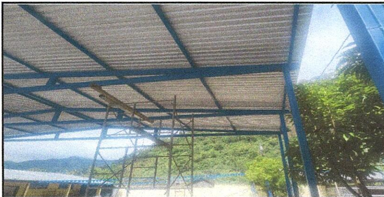
Foto 5: Se realizaron trabajos de detalles mínimos en la estructura y el entechado, consistentes en ajustes y aplicación de pintura de retoque en áreas con daños menores.
