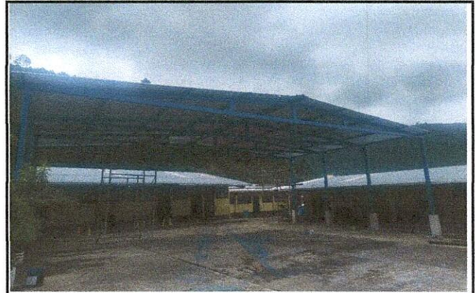
Foto 4: se colocaron las láminas de cubierta sobre las costaneras metálicas, cuidando la alineación, el traslape y la fijación adecuada.
