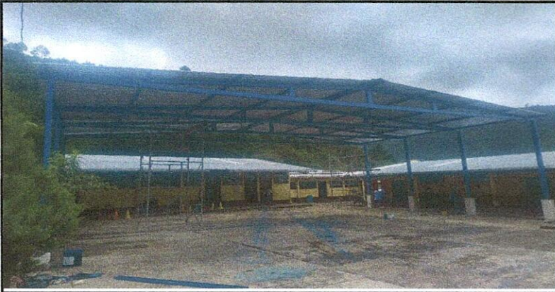
Foto 1: se realizó el pintado de costaneras y vigas para posteriormente instalar las láminas metálicas.
